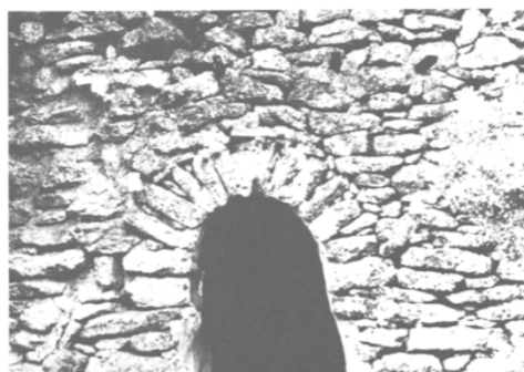
ABANE N°80 PARCELLE 112 QUARTIER BIRON rc de renfort de claveaux composé de pierres plates disposées en arc de cercle. noter l'absence de linteau horizontal monolithique.
